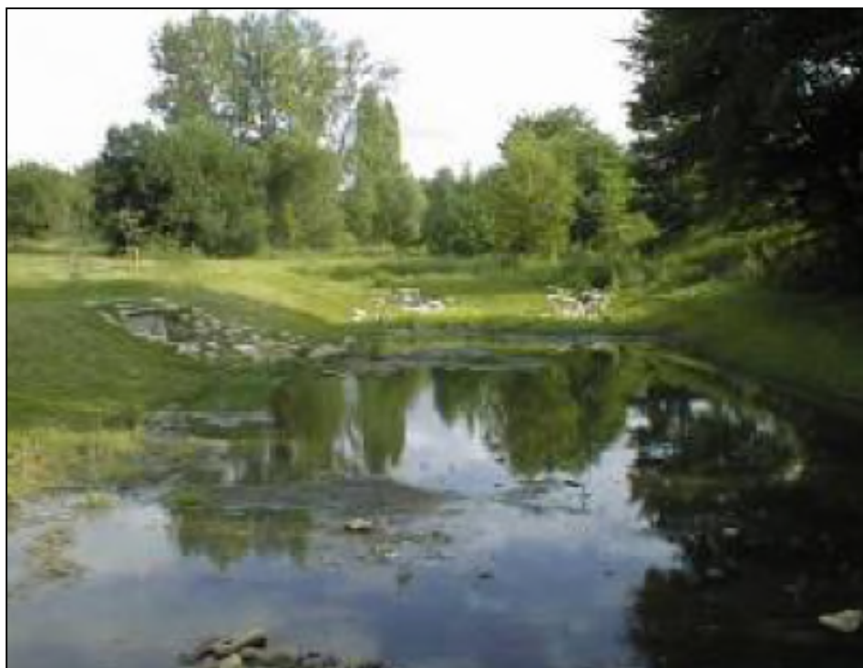
Figure 35 : Bassin paysager en eau
