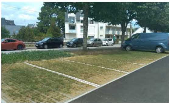
Fonction de stationnement + fonction hydraulique = parkings perméables
