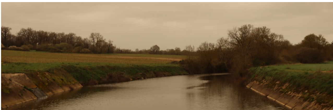
Photo 19. Le Tenu à hauteur de la station de pompage de la Pommeraie
