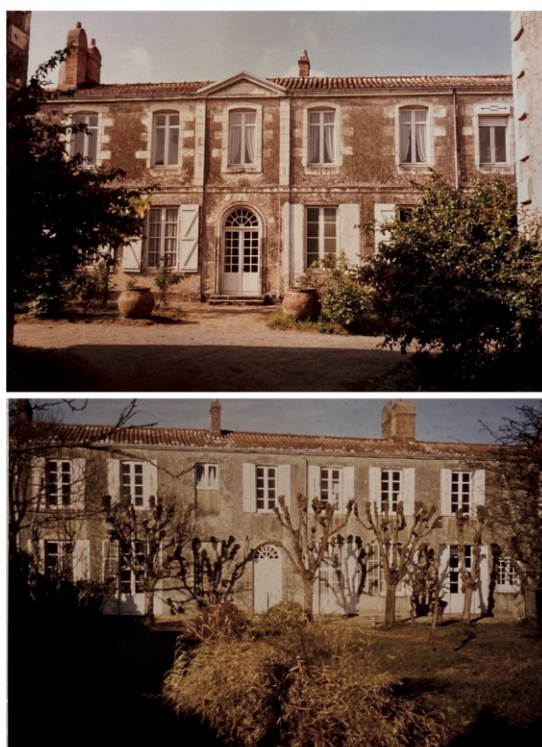
Hôtel Réal des Perrières Inscription MH - 26/03/1992 - façades et toitures (maison, communs, pavillons), jardin
