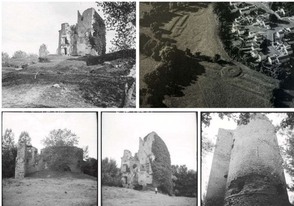
Château dit «Gilles de Retz» et place forte Inscrit MH - 17/03/2004 - éléments bâtis fortifiés subsistants des anciens château et place-forte
