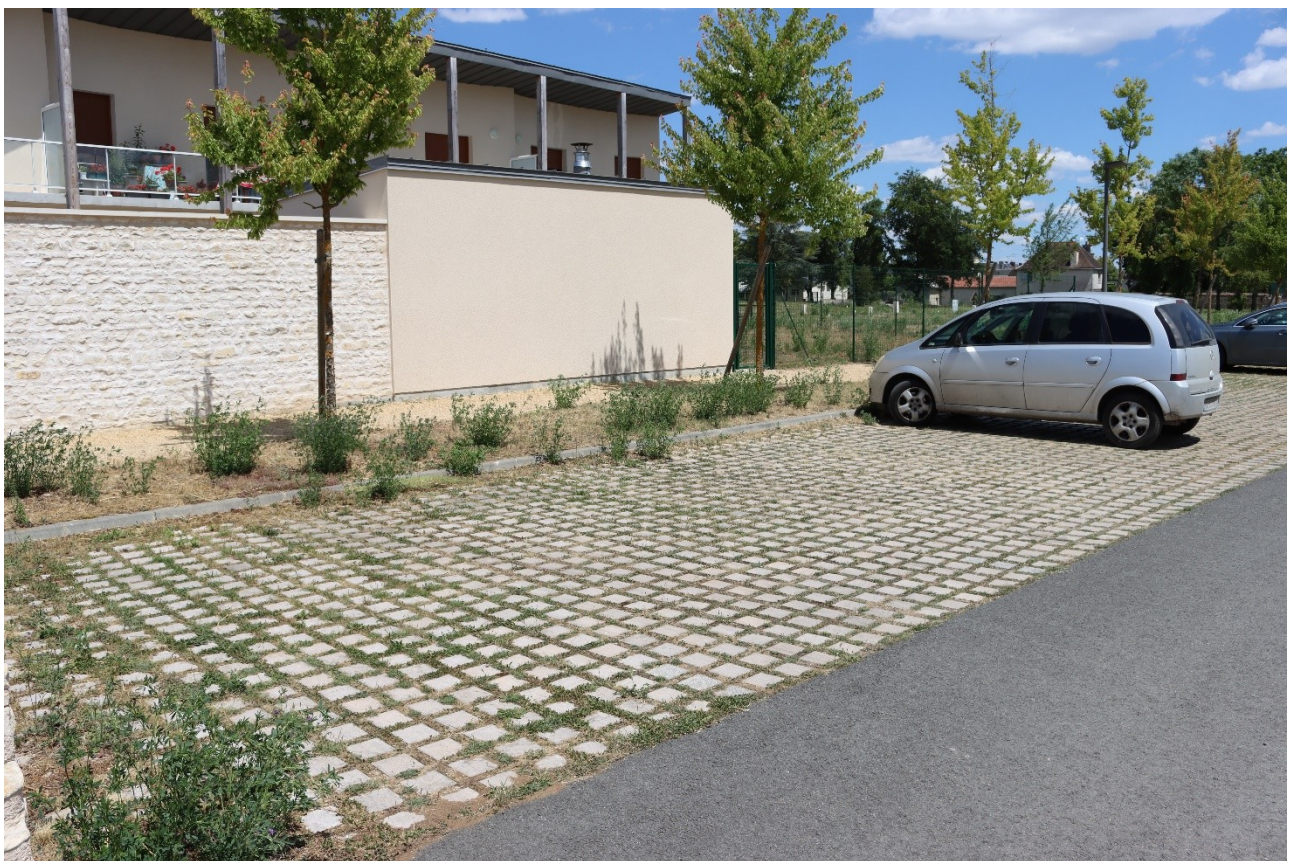
Exemple de stationnement en revêtement perméable – Auddicé Val de Loire
