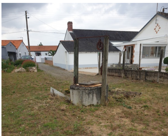
Puit, bâti et zone carrossable sur site
