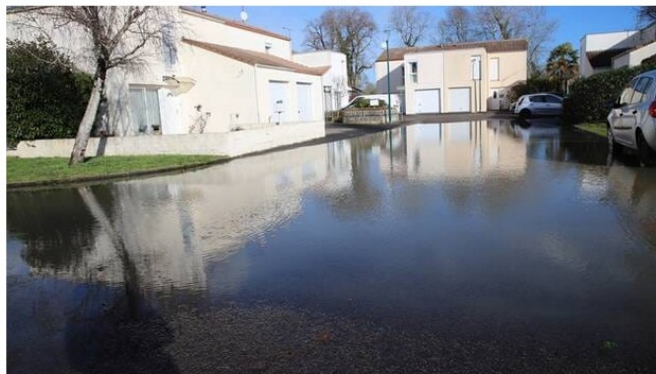
Les fortes pluies de ces dernières heures ont provoqué des inondations, comme ici à Machecoul-Saint-Même. | OUEST-FRANCE
