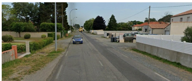
Photo 4. Rue de Nantes en 2023
