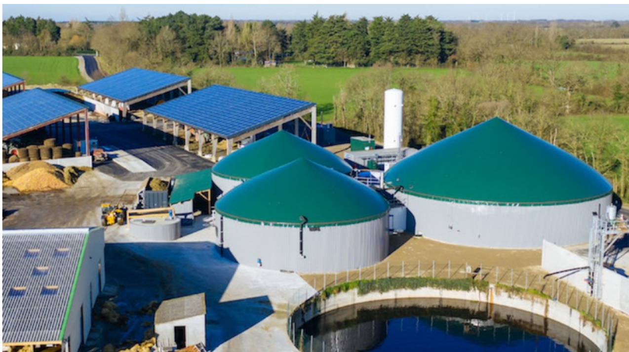
Figure 35. Usine de méthanisation MéthaTreil du du Gaec du Treil
