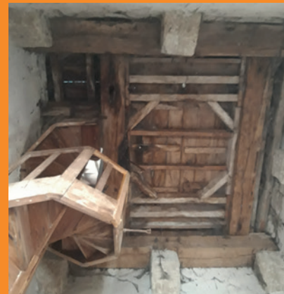
Vue en contre-plongée des poutres
